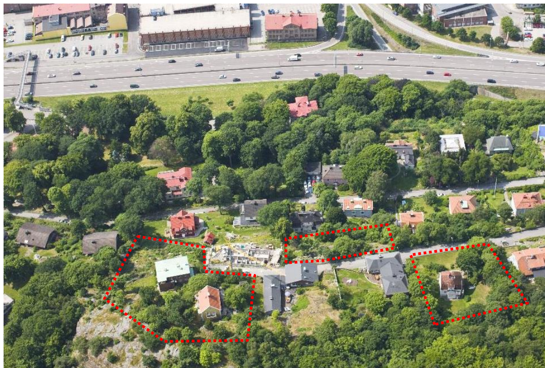
Flygbild tagen från öster. Ungefärligt detaljplaneområde redovisat med röstreckad linje. Bebyggelsen är placerad i en kraftig sluttning ned mot Kungsbackaleden/E20/E6 i väster.
